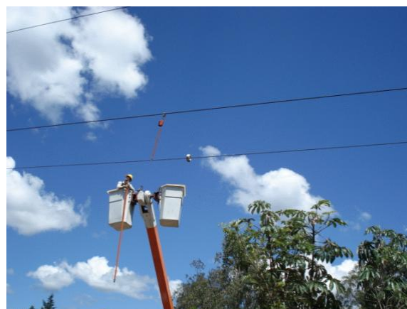
Figura 8. Processo de instalação dos sensores Power Donut-2 em campo utilizando bastão e caminhão isolado.
